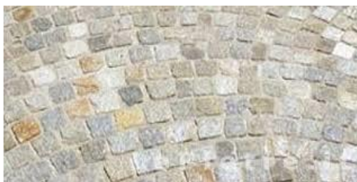
Es. Pavimentazione in pietra di Luserna
